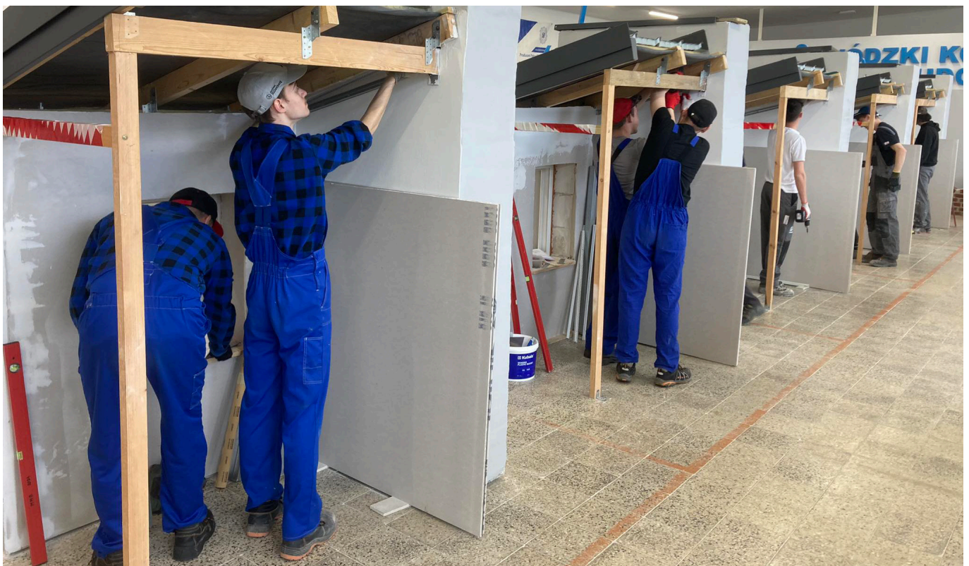
Etap praktyczny konkursu – wykonanie fragmentu przegrody poziomej w technologii suchej zabudowy
